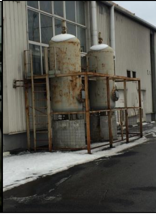
Ресиверы пневмопуска Дымовые трубы
